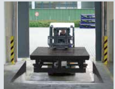
Neue Ladebrücke einsetzen
