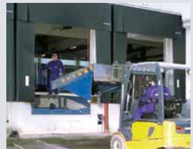
Alte Ladebrücke ausbauen, evtl. Grube anpassen (z. B. mit Montageplatten oder Konsolen)
