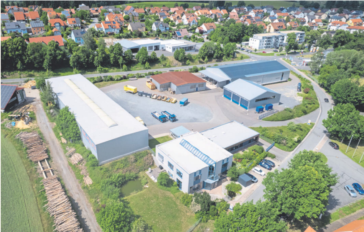
Die Drohnenaufnahme zeigt das Firmengelände der Firma Pöllath am Kreinzelweg in Erbendorf. Im Vordergrund befinden sich das Verwaltungs- und Ausstellungsgebäude, dahinter die Lagerhallen, Garagenflächen sowie die neue Werkstatt. Von dort aus werden jährlich rund 9000 Baustelleneinsätze koordiniert.
