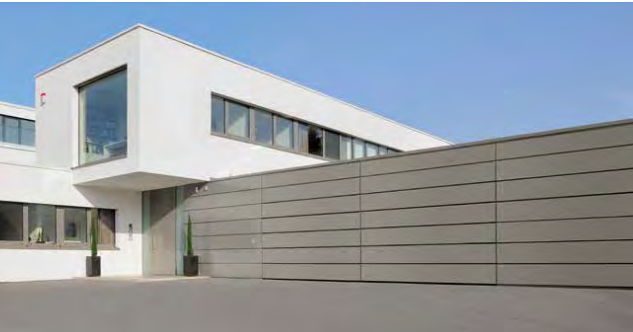
Bauseitige Beplankung mit Aluminium-Verbundplatten
